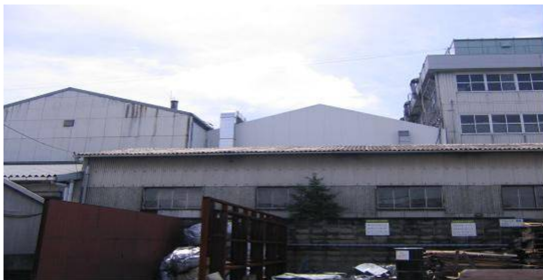
騒音を防止する為外壁を改修した外壁(中央部)
